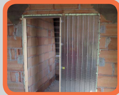
Zapěněné pouzdro ve stavebním otvoru
