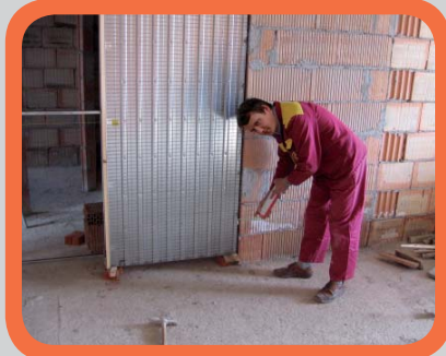
Zapěnění ukotveného pouzdra nízkoexpanzivní montážní pěnou
